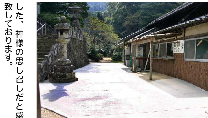
社務所前の舗装
